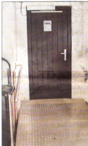
Über eine Rampe ins Haus
