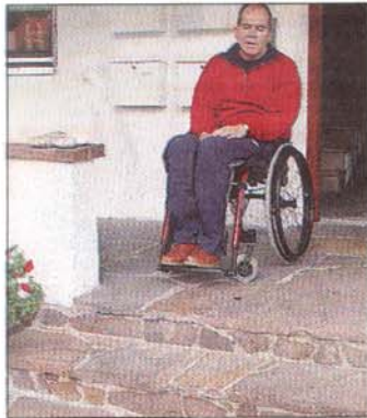
Unüberwindbar: Stufen am Eingang
